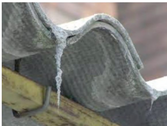
Figura 2 y 3. A la izquierda, plancha de fibrocemento (más conocido en nuestro país por su nombre comercial, uralita). A la derecha, diferentes productos que contienen amianto, entre ellos, prendas textiles.
